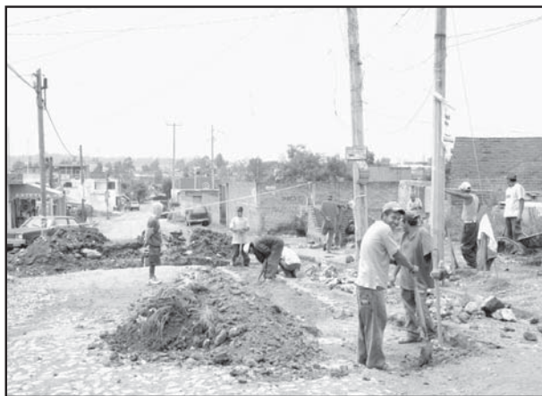
Instalan colectores para desarrollo habitacional
