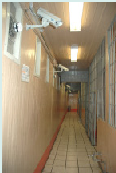
Instalarán cámaras en celdas
